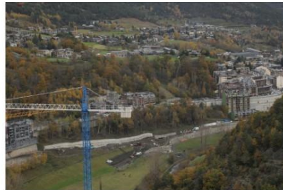
Obreres a la plaça de la Massana - Comú de la Massana
